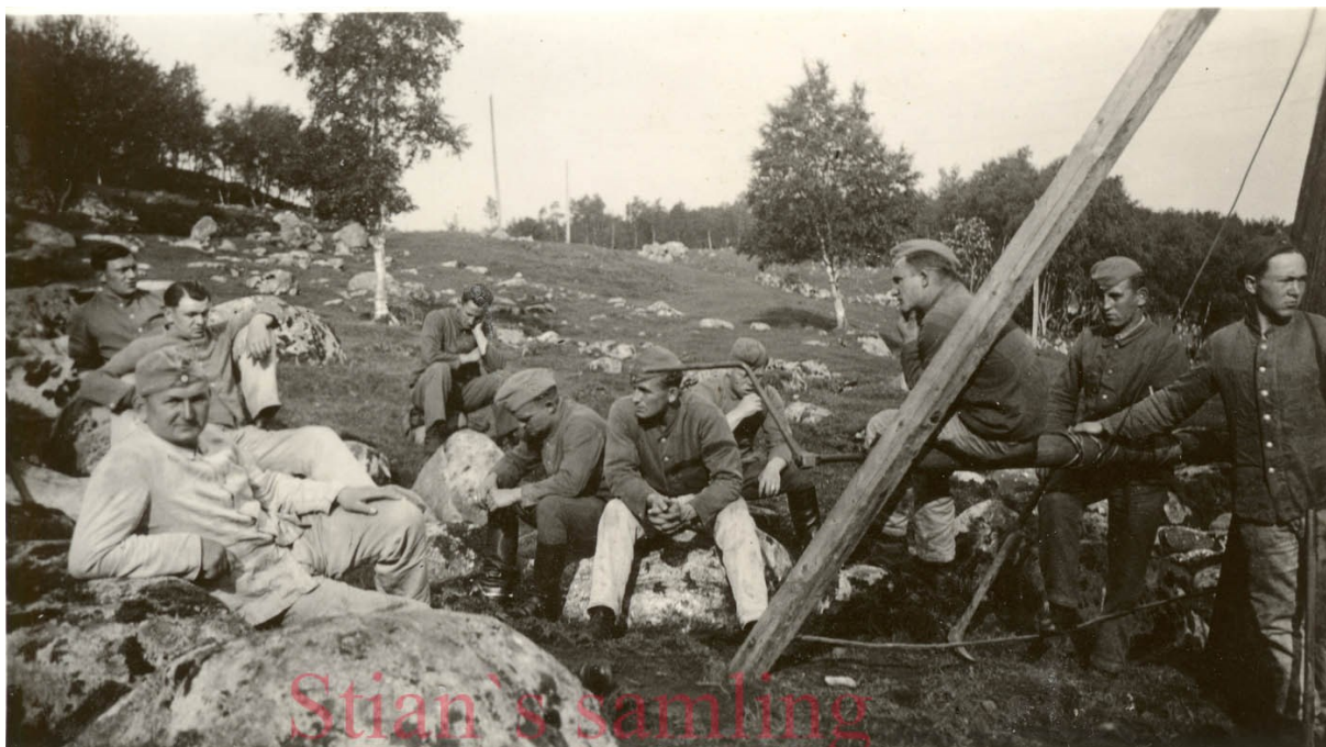
Tyske soldater har pause. Etter 1941 overtok russiske krigsfanger det tunge anleggsarbeidet.
